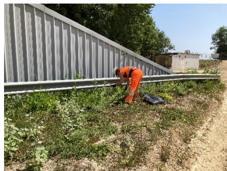
Entfernen von Problempflanzen
