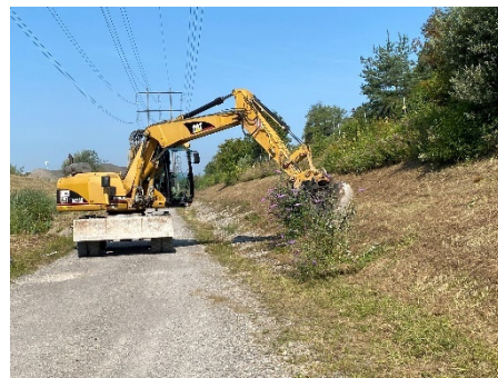
Maschinell wurden Problempflanzen entfernt
